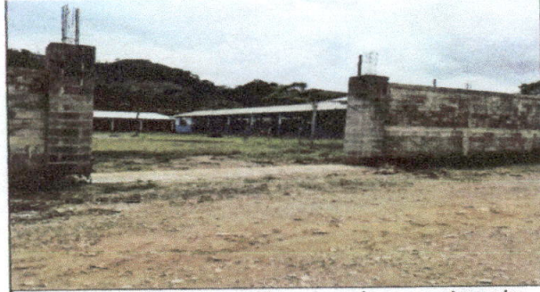
Foto 4: Colocación de Portón metálico, este servirá para mantener a los alumnos del establecimiento seguros ya que la escuela se encuentra a la orilla de la calle y hay mucha afluencia vehicular.
